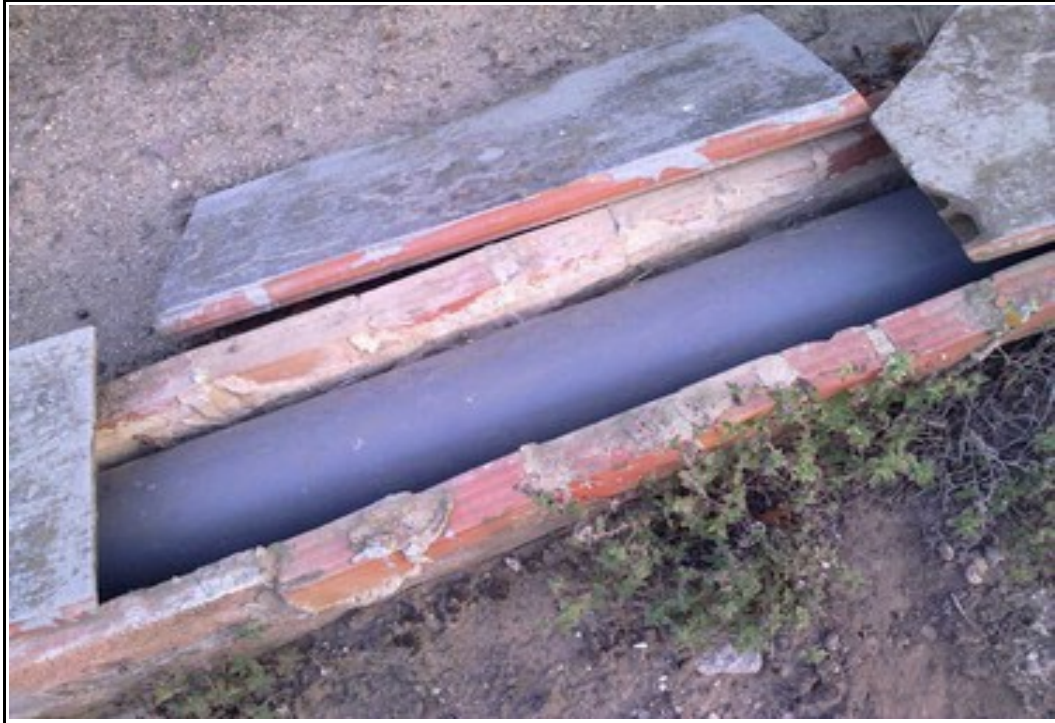
Rec d'obra reconvertit a canonada de plàstic, tapat amb peces d'obra
