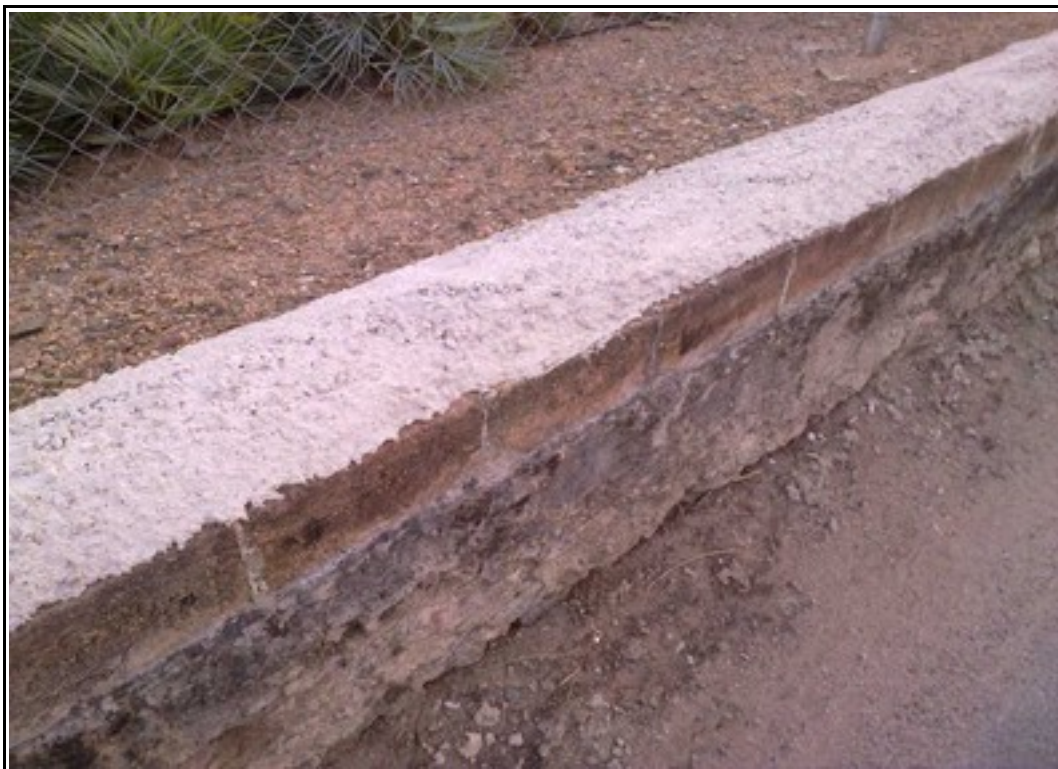
Rec d'obra reconvertit en canonada, tapat amb formigó
